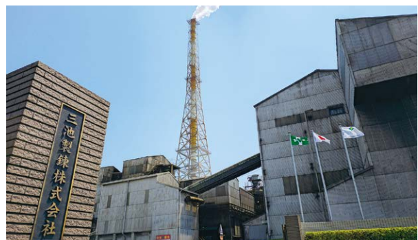
バイオマス燃料による操業試験を行った三池製錬
