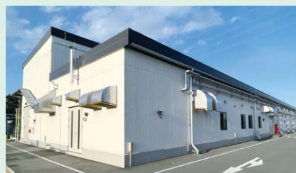
量産試験用設備
