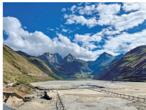
崩壊のリスクが小さいとされる外盛方式を採用しています。社内技術者による巡視や堤体水位のモニタリングに加え、外部機関による安定性評価を受けています。(ワンサラ鉱山、テュスピ鉱さい集積場)
